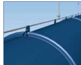
Подвеска Всё-в-Одном на Н-рельсе. Каналы на Н-рельсе быстро устанавливаются и снимаются для стирки.
